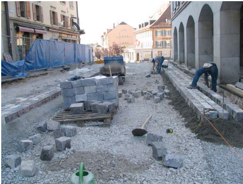
Les travaux d'aménagement de la Grand-Rue de Bulle qui s'achèveront en 2008.
